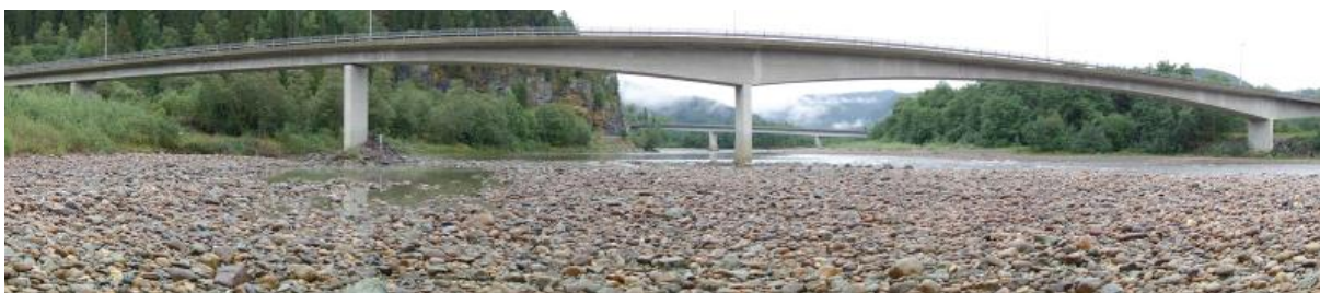
Figur 5 Eksisterende bru over Gaula. I bakgrunnen sees fv. 632 Folstad bru.
